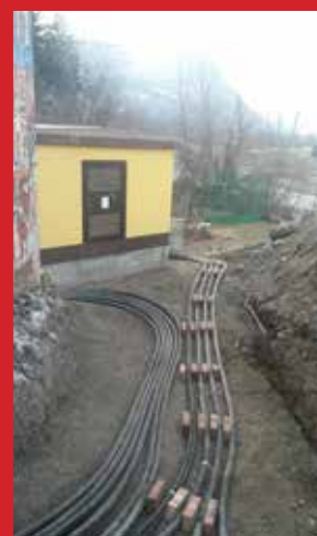
Izgradnja TS „Gusinje 3“ odvija se pod nadzorom dipl. el. inž. Almasa Čekića
