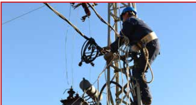
Poslovođa Tomaš Mitrović radi rame uz rame sa kolegama, ne izbjegavajući ni penjanje na stub
