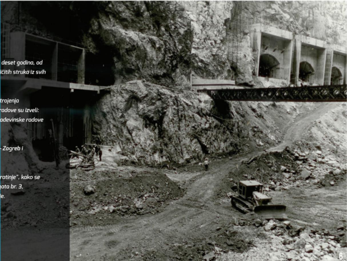
HE "Piva" je akumulaciono priborsko postrojenje i njegovi glavni objekti su: brana, slapište, ulazna gradevina, dovodni cjevovodi, mašinska zgrada sa agregatima, odvodni tunel i razvodno visokonaponsko postrojenje.
